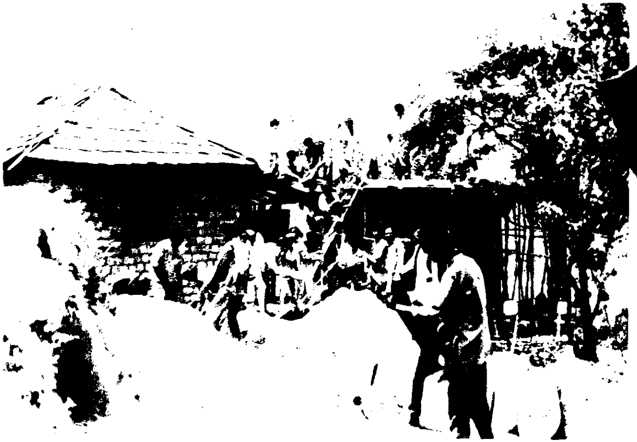
जवाहर रोजगार योजना के अंतर्गत हिमाचल प्रदेश के एक गांव में विद्यालय के भवन का निर्माण कार्य जारी।
